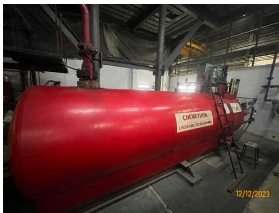
รูปที่ 3-7 ถังเก็บก๊าซคาร์บอนไดออกไซด์
